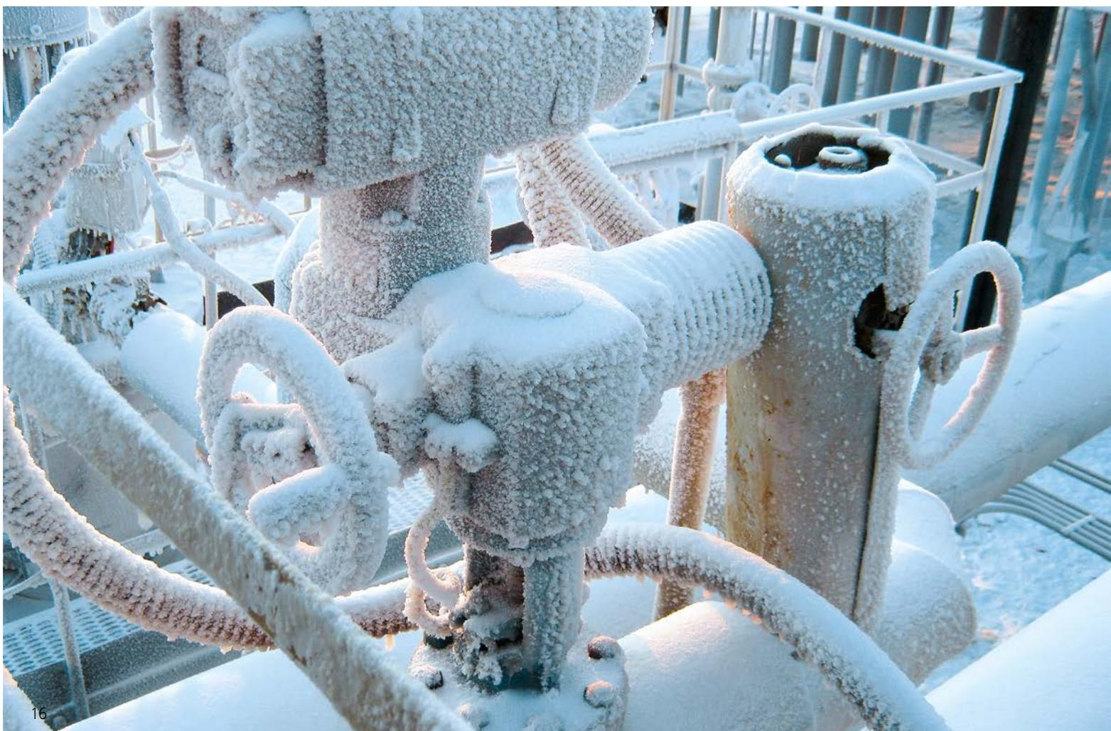
En las instalaciones en las que pueden presentarse atmósferas explosivas se deben utilizar dispositivos con protección anti-explosión. Éstos están contruidos de modo que no puedan convertirse en fuente de ignición. No generan chispas y no presentan temperaturas elevadas en las superficies.
